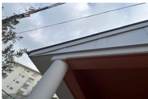
道路側の鼻隠し出隅部分の補修
