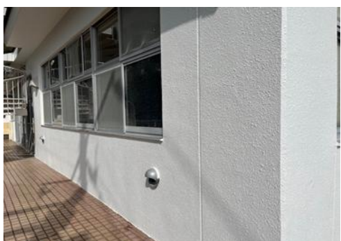
道路側の外壁補修
