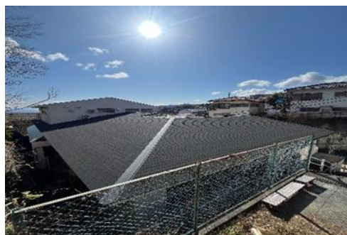
北東側の屋根の補修（内樋撤去）
