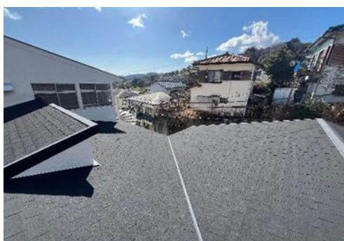
南西側の屋根の補修
