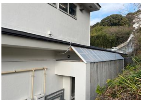
東側の外壁補修
