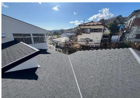
南西側の屋根の補修
