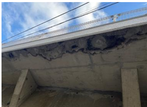
道路側テラス コンクリート補修
