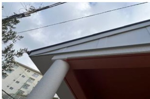
道路側の鼻隠し出隅部分の補修
